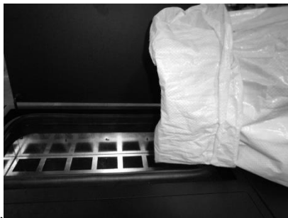
Figura 17 - Reabastecimento do depósito de pellets
