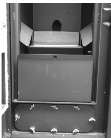
Figura 25 - Limpeza do interior da compacta
