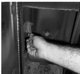
Figura 22 - Limpeza do interior da compacta a água
