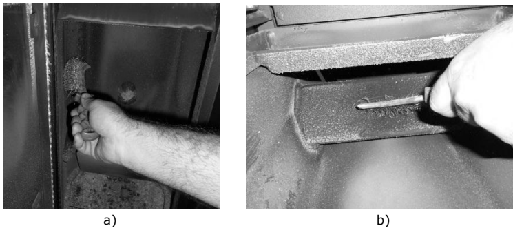
a) Figura 31 - Limpeza do interior da salamandra a água
