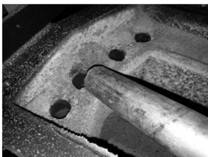
Figura 40 - Limpeza dos canais de passagem de gases e turbuladores
