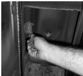
Figura 34 - Limpeza do interior da salamandra a água
