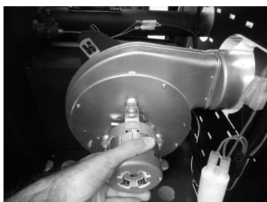
Figura 42 - a) Retirar os parafusos; b) Retirar extractor
