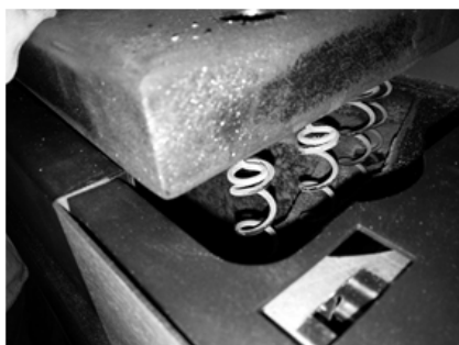
Figura 40 - Limpeza dos canais de passagem de gases e turbuladores
