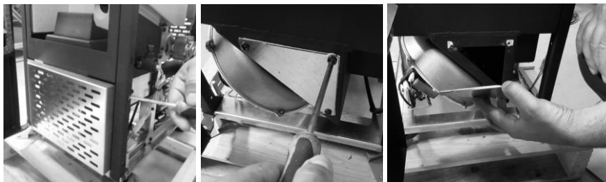
a) Remoção grelha inferior b) Remoção tampa frontal c) Abertura frontal caminho de fumos
